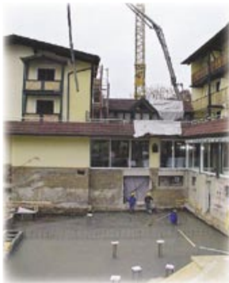
Die Bodenplatte wird betoniert
