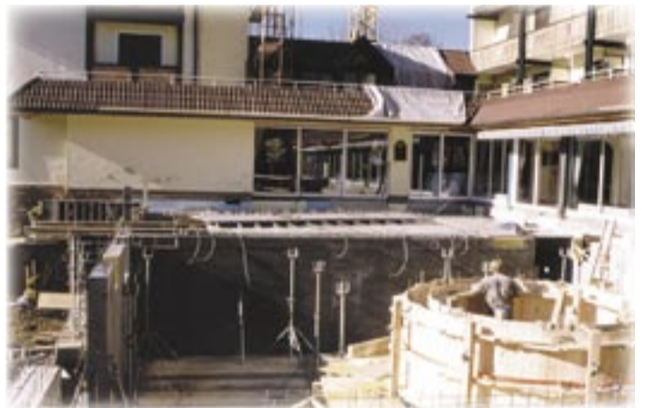
Schalungsarbeiten für die Sauna
