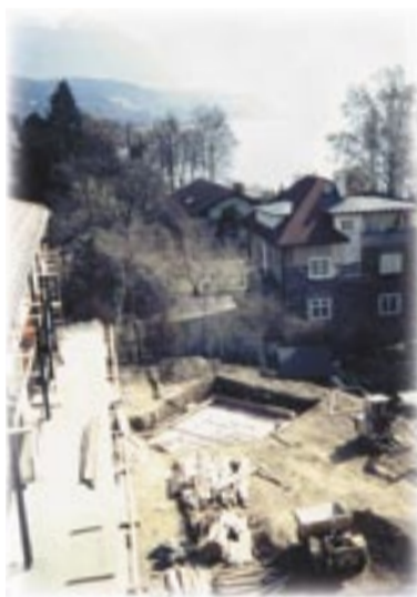
Der neue Pool wird gebaut
