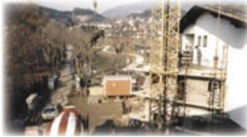
Der Liftturm wird errichtet
