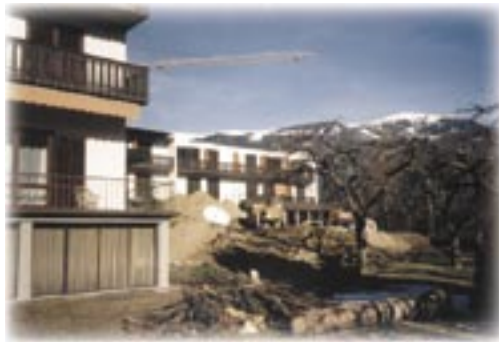
Abriss des alten Dachstuhl
